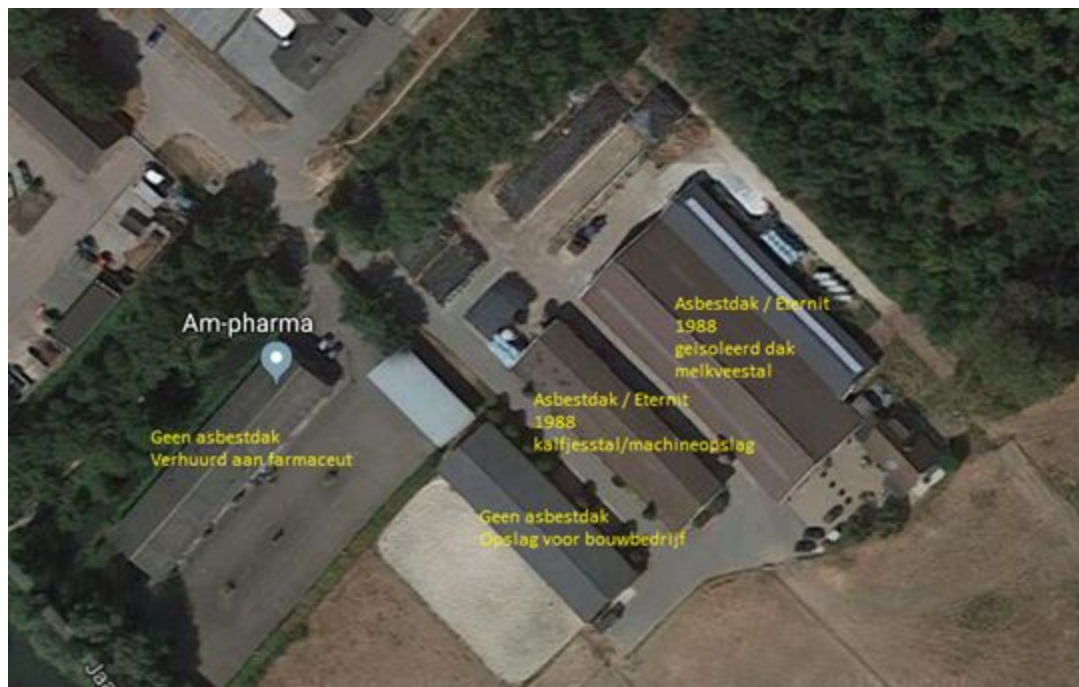
Figuur 9.8.1.: Luchtfoto Rumpsterweg 6-8 te Bunnik met aangegeven de functie per gebouw
