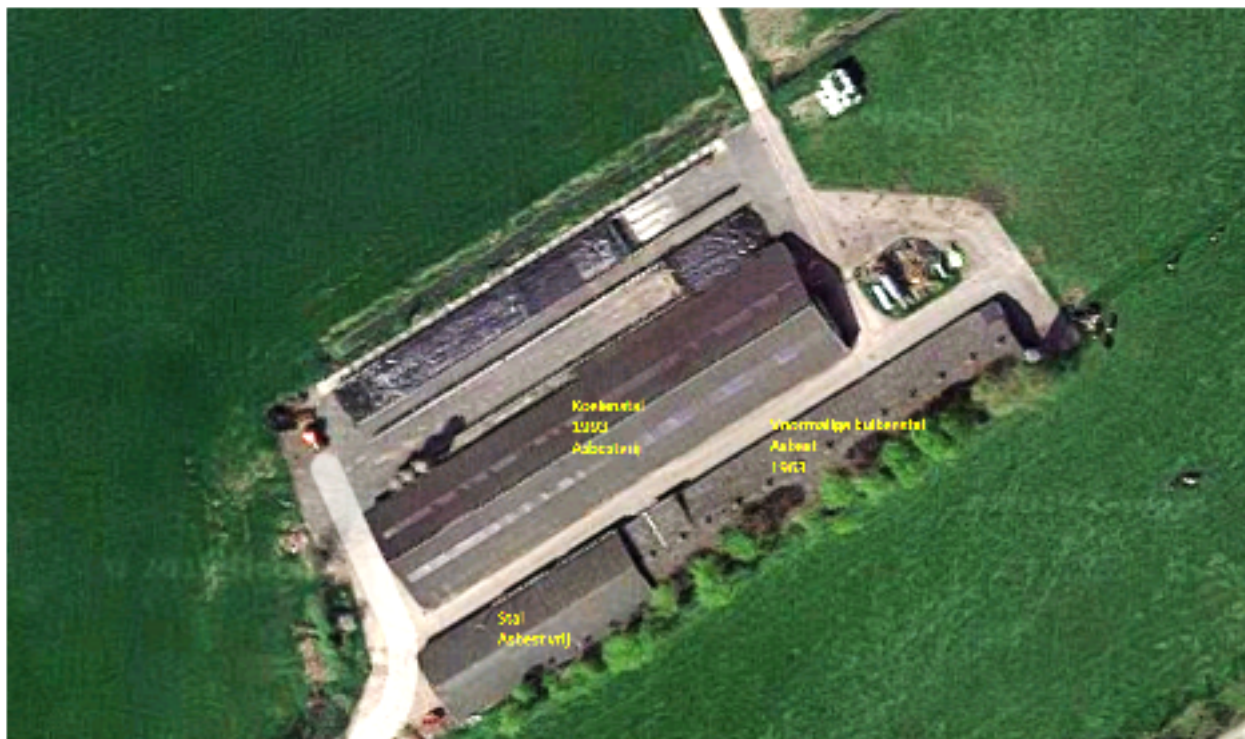
Figuur 9.5.1.: Luchtfoto Lange Uitweg 83 met aangegeven de functie per gebouw
